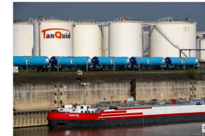
Ein Tanklager von Tanquid im Hafen von Duisburg. (Jochen Tack/MAGDO)
